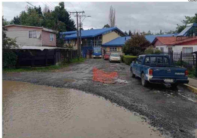
CUANDO LLUEVE, LAS INMEDIACIONES DE LA ESCUELA SE INUNDAN DE POZAS CON AGUAS SERVIDAS.
