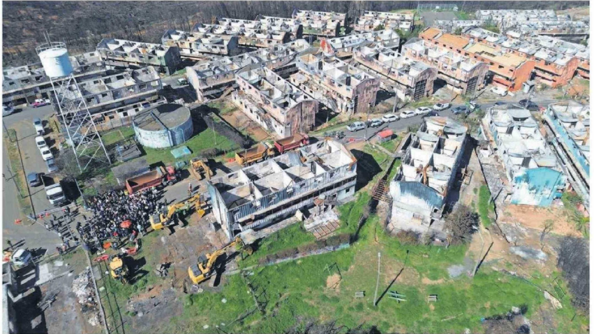
La semana pasada comenzó el proceso de demolición de los block de Ríos de Chile en Lirquén, una de las zonas más siniestradas tras los incendios de enero.
