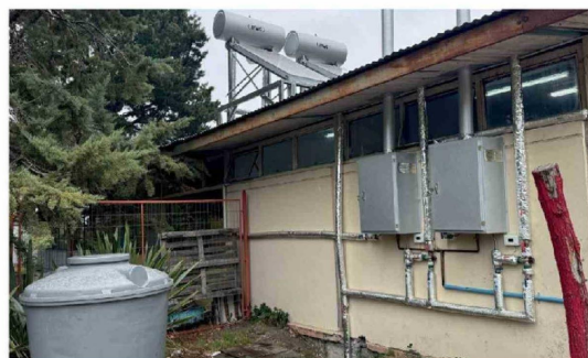
SISTEMA CONSIDERA DOS EQUIPOS TERMOFÓN de 150 litros cada uno, con respaldo mediante calefones y red de distribución interna certificada para abastecer al establecimiento.
