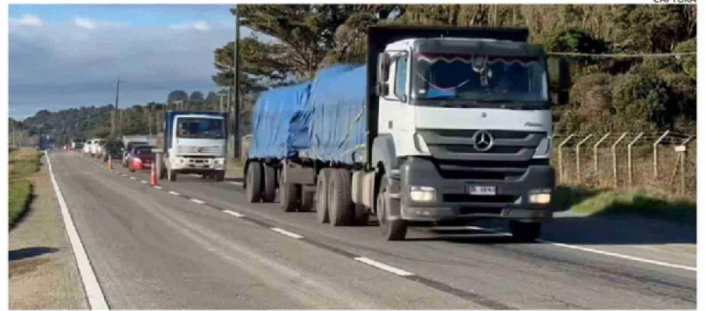
EN LA DEMARCACIÓN DE LA VÍA ENTRE CHACAO Y EL PUENTE PUDETO SE ESTÁ TRABAJANDO.
