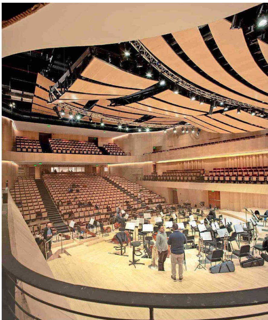
La gran sala sinfónica cuenta con un plafón acústico suspendido sobre el escenario.
