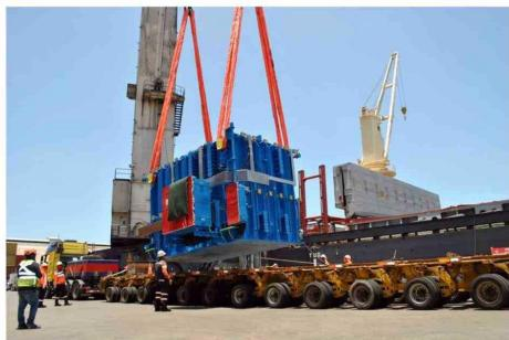
Iquique Terminal Internacional (ITI) consolidó su capacidad para atender operaciones de alta complejidad logística al concretar un nuevo hito con la descarga de cuatro transformadores destinados a la industria minera, cada uno con un peso de 122 toneladas, mediante una maniobra en tandem ejecutada
