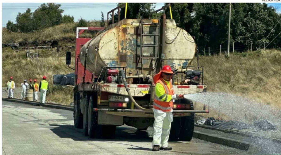
TRABAJOS EN EL ACCESO NORTE AL BAIPÁS DE CASTRO REALIZADOS DURANTE LAS ÚLTIMAS SEMANAS DE FEBRERO.
