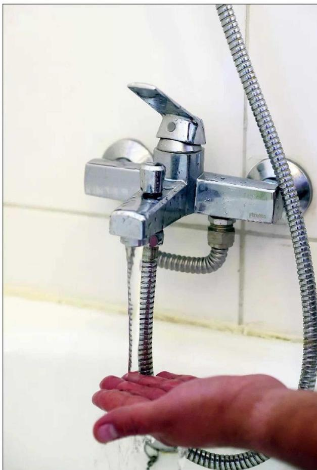
El flexible que se ubica bajo la llave permite la recirculación del agua caliente.
