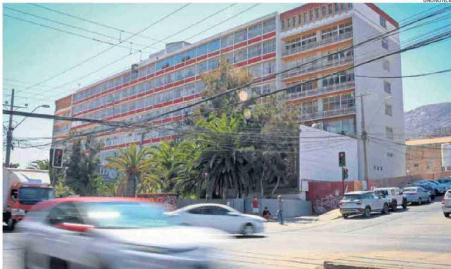
LA CASA DE ESTUDIOS GESTIONA PARTE DEL EDIFICIO DEL EXHOSPITAL REGIONAL DESDE EL AÑO 2018.
