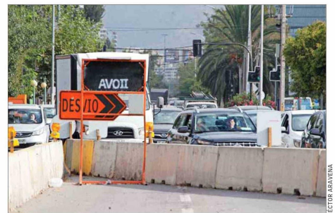
CORTES. — Obras como las de la autopista Américo Vespucio Oriente (AVO) II han generado cortes de pistas y desvíos que aumentan los atochamientos.
