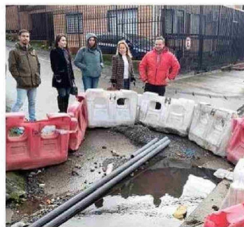
LAS OBRAS DEL SUMIDERO EN J.J. MIRA CON FREIRE.
