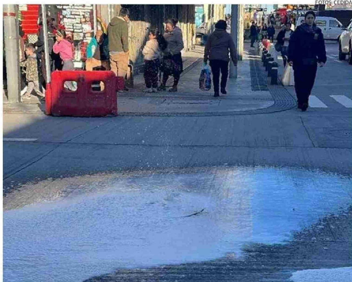
OLORES NAUSEABUNDOS EMANARON DESDE ESTA TAPA DE ALCANTARILLADO EN VARAS CON ANCUD.
