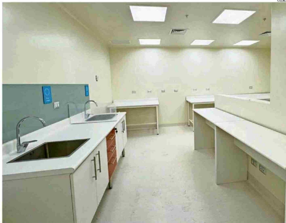
NUEVAS DEPENDENCIAS DE LA UNIDAD DE MEDICINA TRANSFUSIONAL DEL NUEVO HOSPITAL. A LA ESPERA DE ESTAR TERMINADAS
