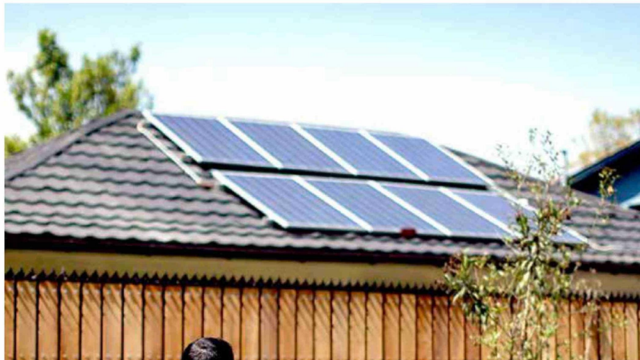
Paneles solares ayudan a ahorrar algunos pesos a quienes los instalan.
