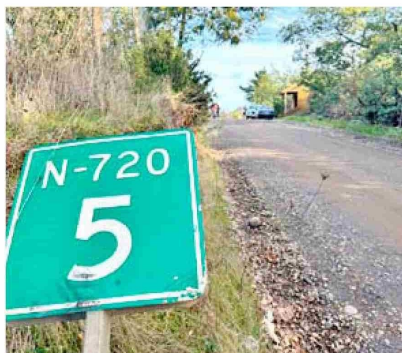
Obras a cargo de la Dirección de Vialidad del Ministerio de Obras Públicas, beneficiarán directamente a las comunidades de las rutas N-720, N-802 y S/R N-862.
