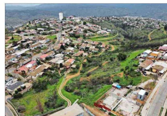
DAÑOS. — Los reclamantes hicieron notar que la zona del humedal fue alcanzada por el megaincendio de 2024.
