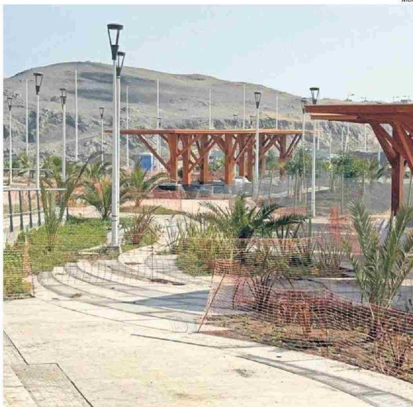
AUTORIDADES REALIZARON UNA VISITA INSPECTIVA A LAS OBRAS.
