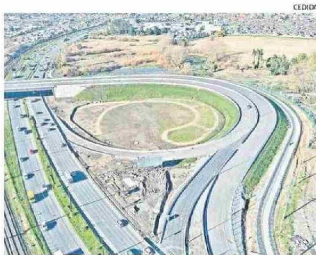
OREJA VIAL DEL INGRESO SUR A PUENTE INDUSTRIAL, EN BOCA SUR.
