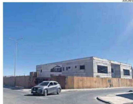
LAS OBRAS CIVILES SE RETOMARÁN EN EL SEGUNDO SEMESTRE DEL 2026.
