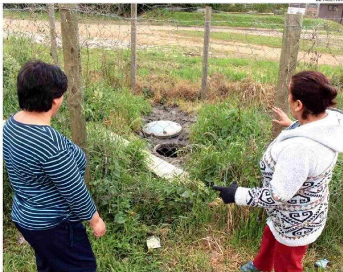
AHORA SE DESTINARÁ EXCLUSIVAMENTE UN CAMIÓN PARA LA LIMPIEZA DE LA FOSA CON AGUAS SERVIDAS.
