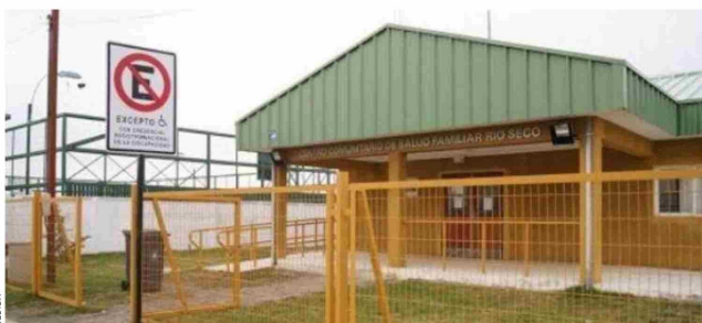
Las obras del Cecosf Río Seco no inician, según, por la firma de la ministra de Salud, Ximena Aguilera.
