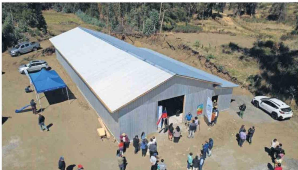
El espacio cuenta con un 60% de avance en su construcción.
