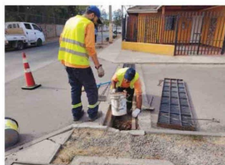
EN LAS POBLACIONES SE DESTAPAN CANALETAS SUBTERRÁNEAS.
