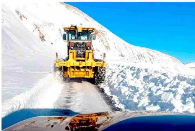
Dentro de los sectores con afectaciones, está el Paso Internacional Pehuenche.
