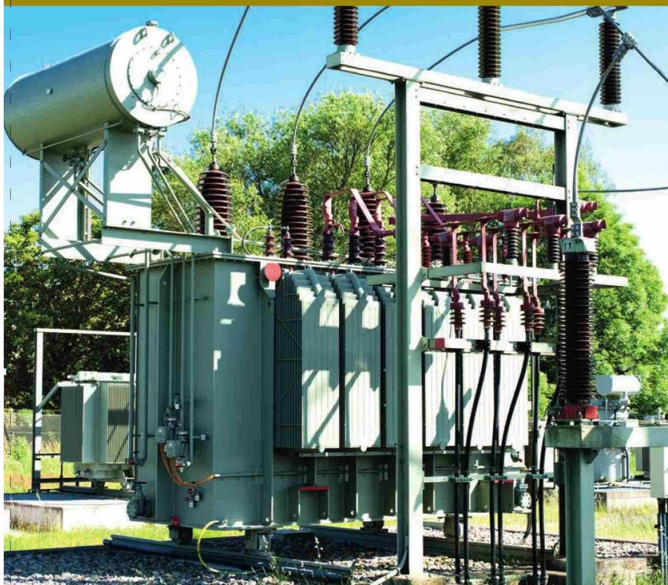
Un transformador eléctrico es un dispositivo estático que transfiere energía entre circuitos mediante inducción electromagnética, modificando los niveles de tensión sin alterar la frecuencia. Hoy en día, constituyen un pilar fundamental en los sistemas de transmisión y distribución de energía, así como en aplicaciones industriales de gran escala.
