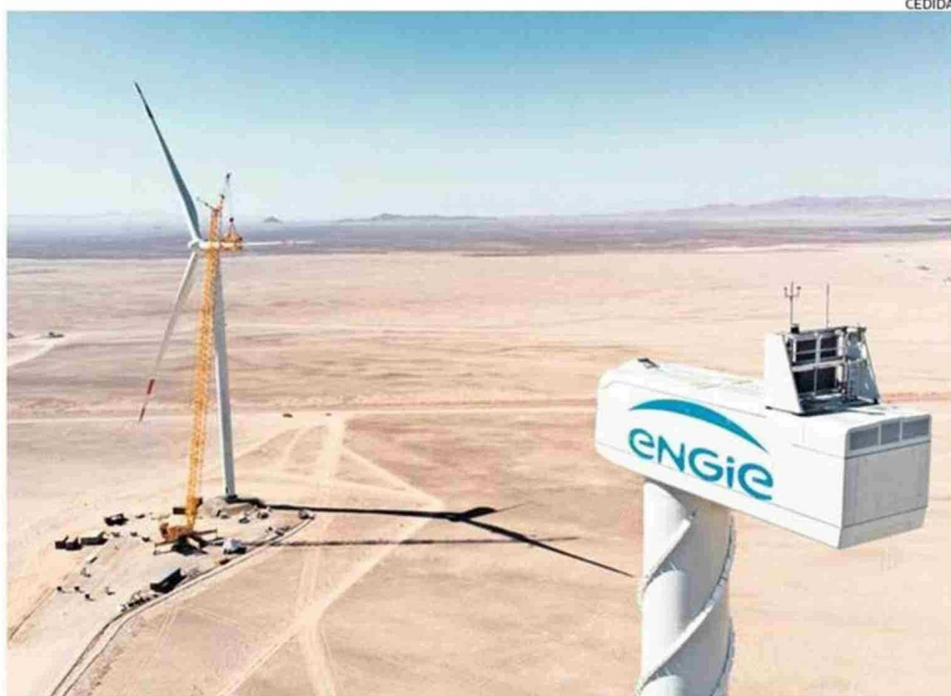
LOS 51 AEROGENERADORES DEL PROYECTO CONSTARÁN DE UNA POTENCIA NOMINAL DE 6,6 MWp CADA UNO.
