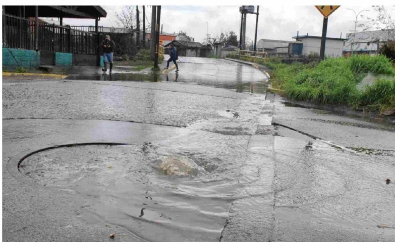
EL AGUA CONTINUABA SALIENDO por las tapas de alcantarilla del sector sur de Los Ángeles durante la mañana de este jueves.
