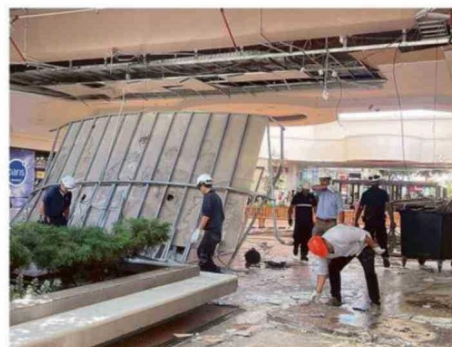
RETIRO DE ESCOMBROS OCASIONADOS POR EL DESPRENDIMIENTO.
