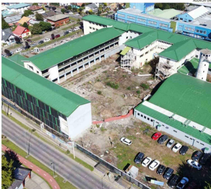
LAS OBRAS DEL LICEO ESTÁN ABANDONADAS DESDE MAYO DEL 2022, POR LO QUE LUCEN DETERIORADAS.
