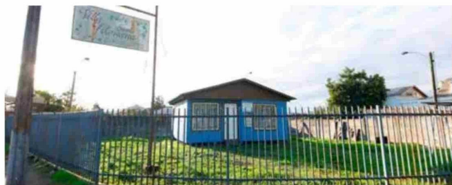
La planta de aguas servidas de Santa Filomena en Isla de Marchant, requiere de urgentes reparaciones.
