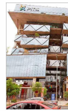
El comandatario se instalará en el edificio PITTS Núcleo Bellavista en Recoleta.
