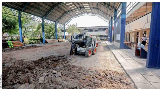
TRABAJOS. — Como parte de una inversión total de $2.800 millones, el “Plan Verano” destinará $700 millones para mejorar las condiciones de los colegios de la comuna de Santiago antes de la vuelta a clases.
