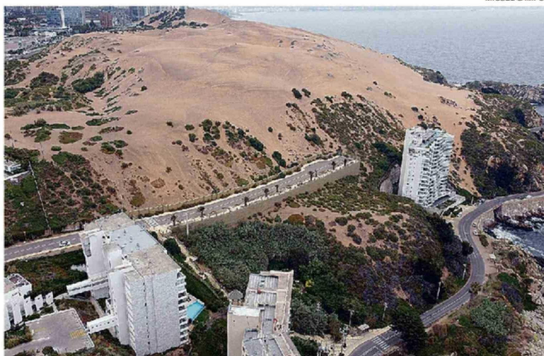
OBRA HABILITARÁ CUATRO LOTES EN CALLE CORNISA PARA EL DESARROLLO DE PROYECTOS INMOBILIARIOS.
