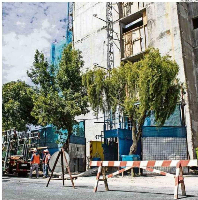
HASTA ENERO, SE PROYECTABAN 23 PROYECTOS DE EDIFICIOS CON MÁS DE 2 MIL DEPARTAMENTOS.
