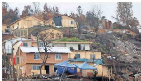
En Penco se cubrieron viviendas en proceso de reconstrucción.
