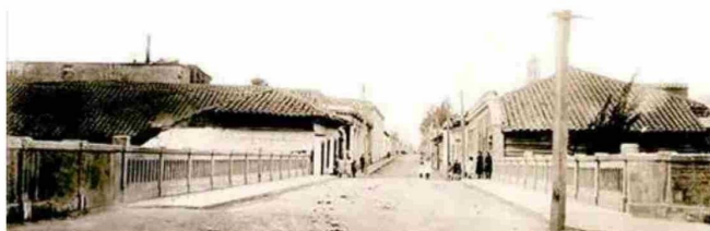
Esta escena tiene 100 años, es de 1925. Se aprecia claramente el puente que está sobre el río Píduco, en el extremo poniente de Talca, de lo que en ese tiempo era simplemente la angosta calle 2 Sur. Todo cambió, tres años después, a raíz del devastador terremoto, grado 8 Richter, del 1 de diciembre de 1928, cuyo epicentro se localizó cerca de Curepto. En toda la provincia hubo más de 300 muertos y quedaron destruidos numerosos edificios y casas, la mayoría de las cuales eran de adobe. Por ello cambió la 2 Sur e incluso se enanchó hasta lo que es hoy.
