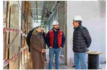
DISPOSITIVO DE SALUD SANCARLINO AVANZA EN SU CONSTRUCCIÓN.
