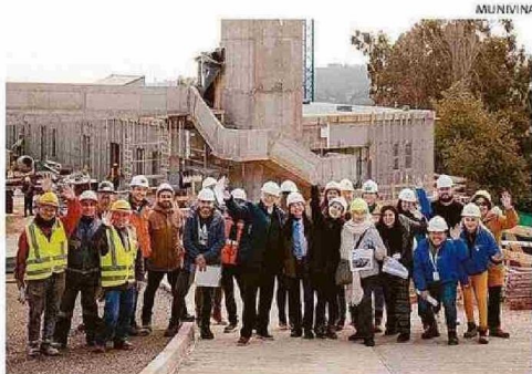
COMUNIDAD DE MIRAFLORES VISITÓ LAS OBRAS DEL NUEVO SAR.
