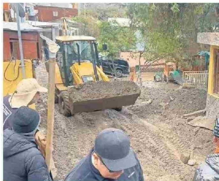
MOP YA INICIÓ OBRAS DE RESTABLECIMIENTO DE CAMINOS.
