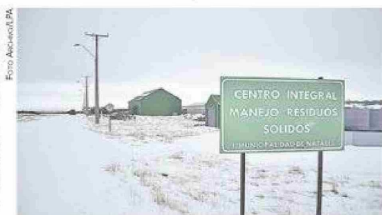
El relleno sanitario se debería haber inaugurado en 2021.
