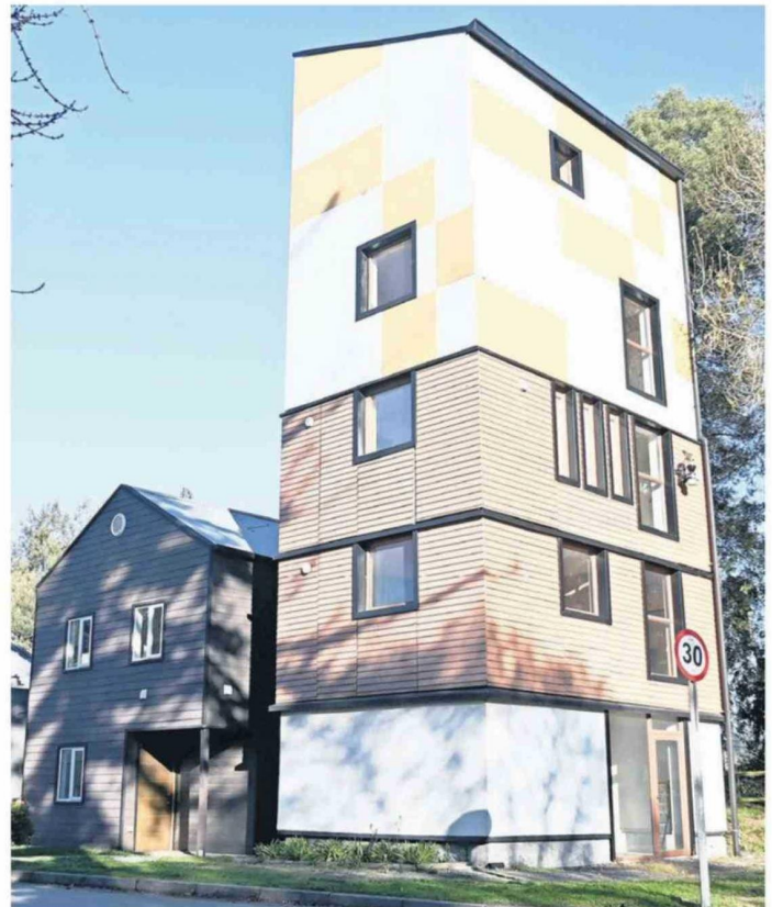
Edificio experimental Pyme Lab, ubicado a un costado del Centro de Investigación en Tecnologías de la Construcción (CITEC-UBB).
