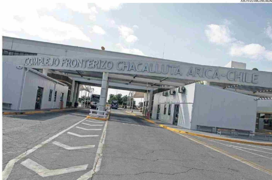
ASÍ LUCE HOY EL COMPLEJO FRONTERIZO CHACALLUTA, A LA ESPERA DE SU TAN ANHELAGADA CONSERVACIÓN Y MODERNIZACIÓN.
