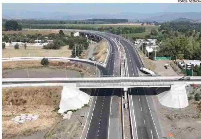
EL PARLAMENTARIO DIJO QUE LAS FALENCIAS QUE HA PRESENTADO LA OBRA HA GENERADO MOLESTIA EN VECINOS DE LA ZONA.
