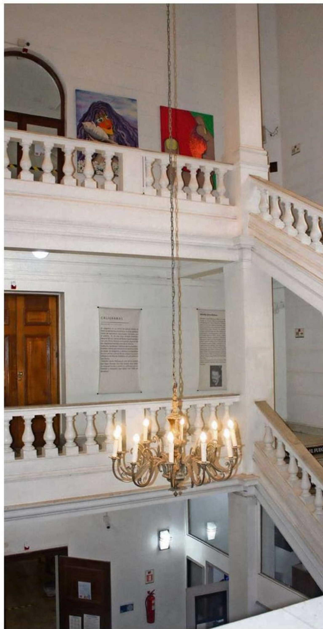
EL INMUEBLE FUE REPARADO TRAS SUFRIR DAÑOS DEBIDO AL TERREMOTO DE 2010.
