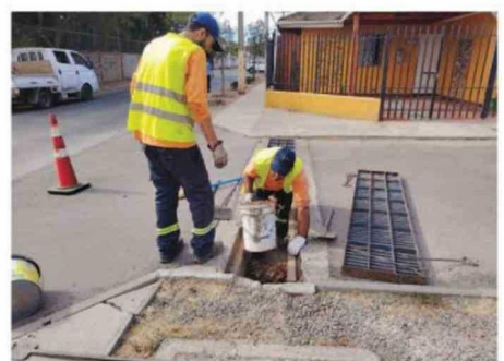
EN LAS POBLACIONES SE DESTAPAN CANALETAS SUBTERRÁNEAS.
