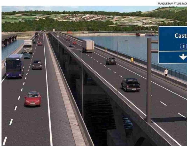
EN ANCUD EL PROYECTO CONSIDERA UN NUEVO PUENTE SOBRE EL RÍO PUDETO.
