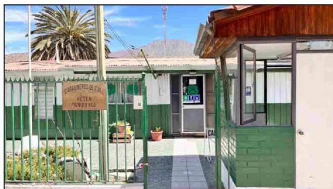
MOP definirá qué empresa se hará cargo de construir la nueva tenencia de Carabineros de Panquehue.
