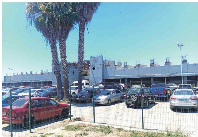
El mercado del Mar en Coquimbo, es uno de los proyectos de infraestructura que ha estado años en abandono y que será recuperado.
