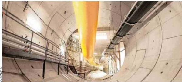
Las tecnologías desarrolladas por Bekaert permiten mayores niveles de resistencia, reducción de tiempos constructivos y mejoras en seguridad operacional en infraestructura subterránea.
