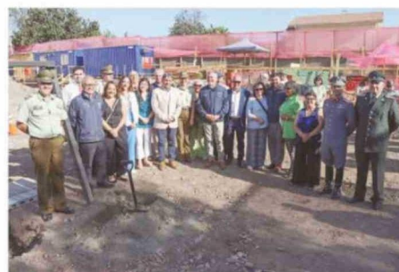
510 DÍAS DE EJECUCIÓN TIENE CONTEMPLADA LA OBRA.
