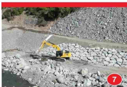
DOH del MOP ejecuta trabajos de protección del sistema de riego
